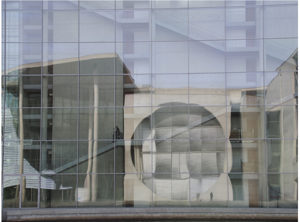
Glasfassade des Paul-Löbe-Hauses, in der sich die Fassade des gegenüberliegenden Marie-Elisabeth-Lüders-Haus spiegelt
